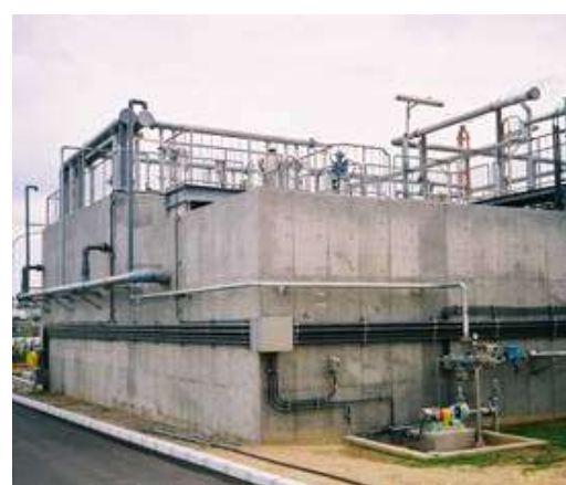
三相流動槽と沈降槽の一体施工例
